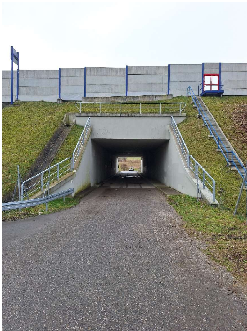
Zdj. 1. Widok z boku obiektu mostowego M42
