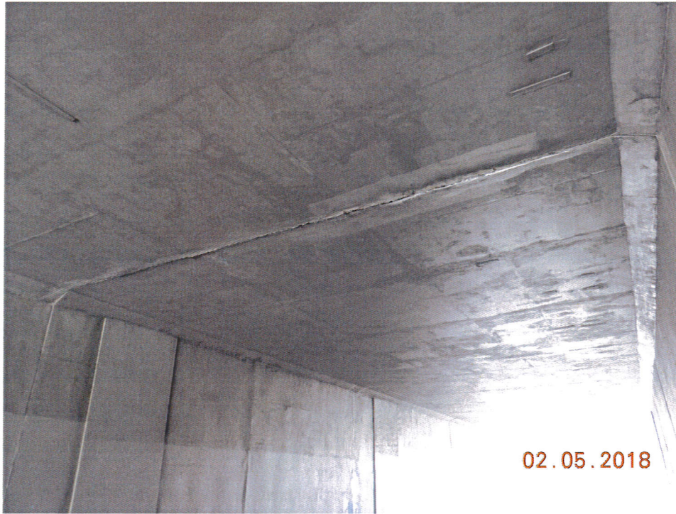
Zdj. 4. Obiekt M28 – dylatacja między segmentami ramy pod jezdnią w kierunku Krakowa
